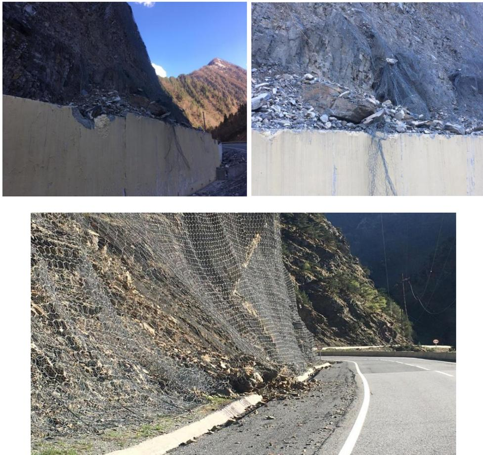
Рис. 2. Защита рыхлых откосов стальной сеткой
