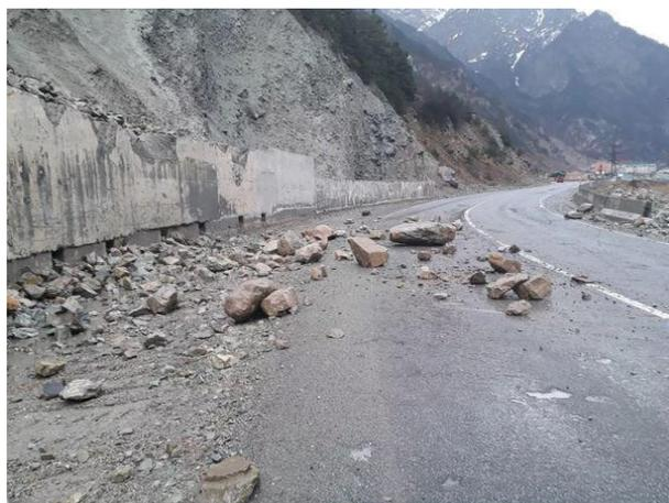
Рис. 1. Создание опасных условий для движения при обвально-осыпных явлениях
