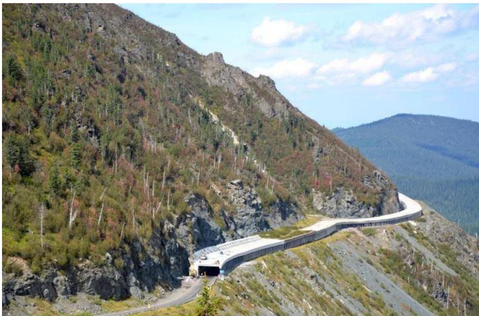
*Рис. 4. Галерея – защита дороги от обвалов на отвесных откосах (Альпийский пример)*
