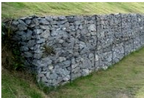
Рис. 1. Габионная конструкция (фото)
