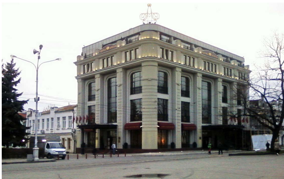
Здание универмага после реконструкции под отель «Александровский». Современный вид
