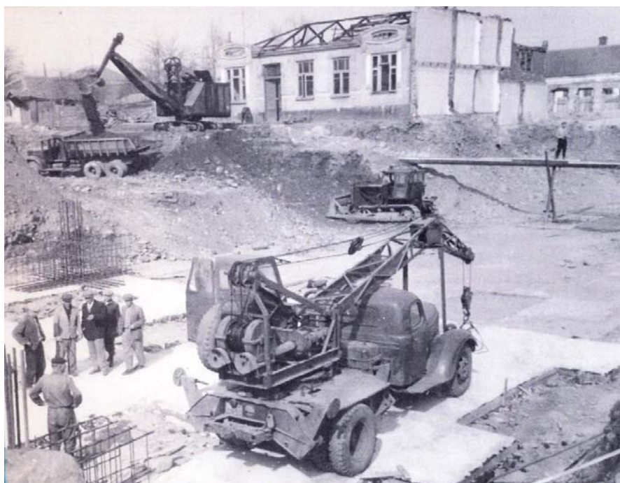
Расчистка площадки под строительство гостиницы «Интурист» (г. Владикавказ), апрель 1965 г.
