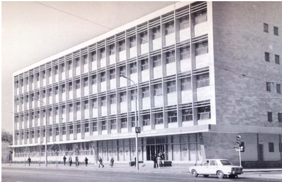
Междугородная телефонная станция на ул. Кирова, 45. Фото 1974 г.
