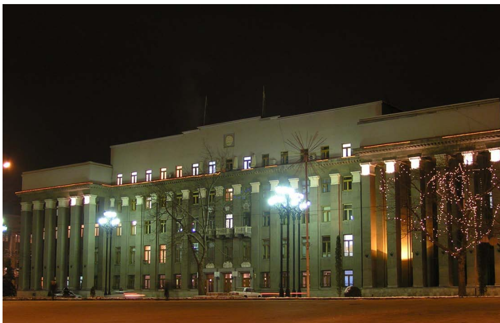
Дом правительства на месте Царской беседки. Современное состояние
