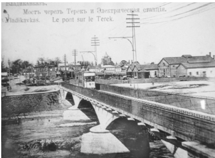
Рис. 1. Общий вид моста.
