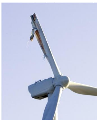
Рисунок 3 – Полное повреждение лопасти
