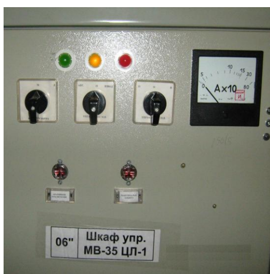
Рисунок 1 – Шкаф управления масляным выключателем МВ - 35 ЦЛ - 1
