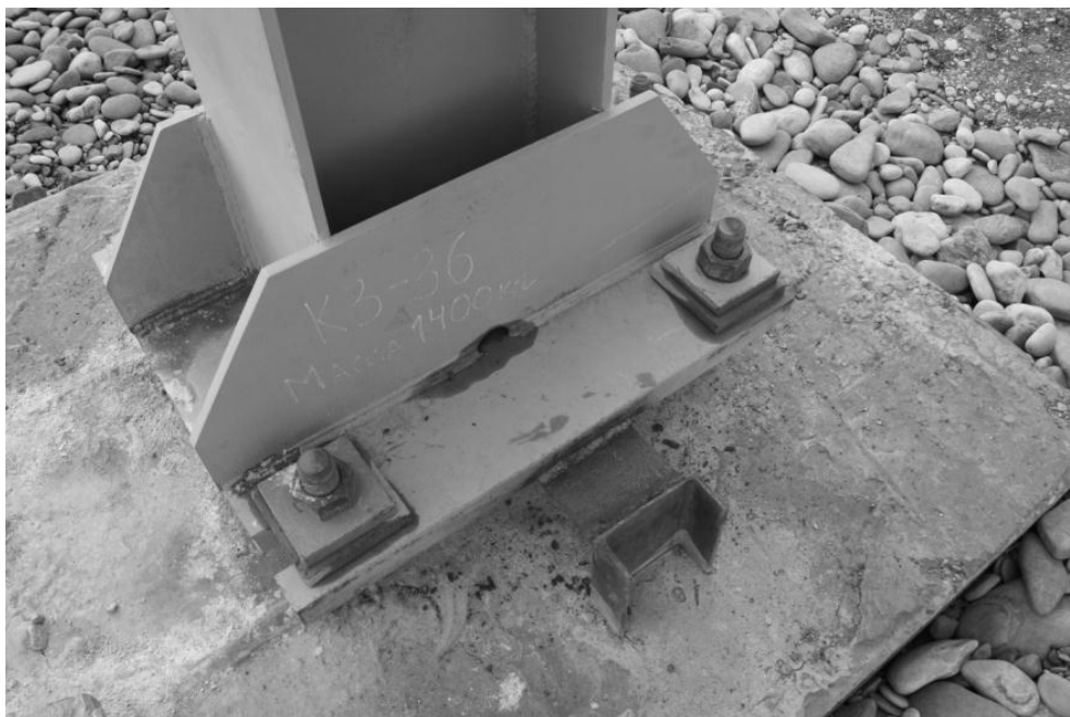
Рис. 5. Обетонирование базы металлической колонны
