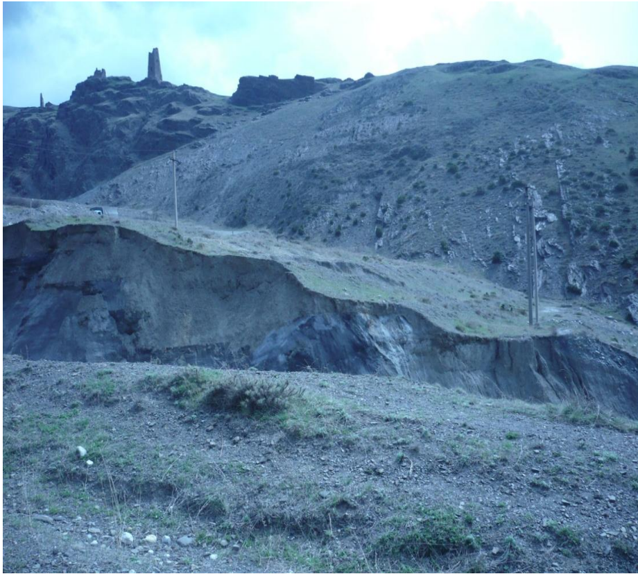
Рис. 2. Тело Фиагдонского хвостохранилища после прорыва тоннеля
