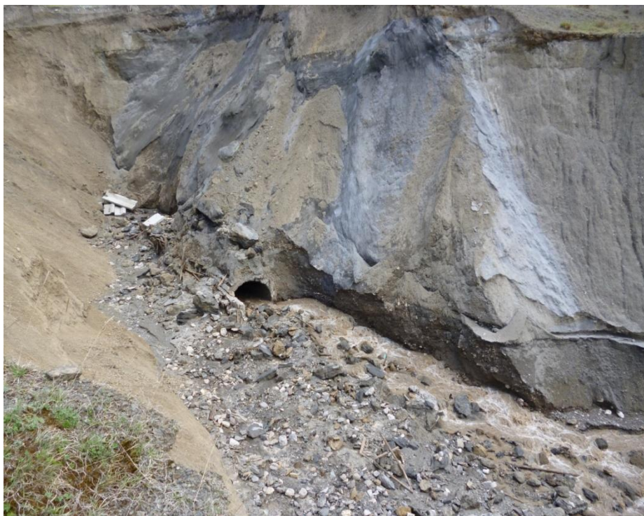
Рис. 3. Фрагмент смыва тела хвостохранилища после прорыва тоннеля речным потоком Хаником-дон (2011 г.)
