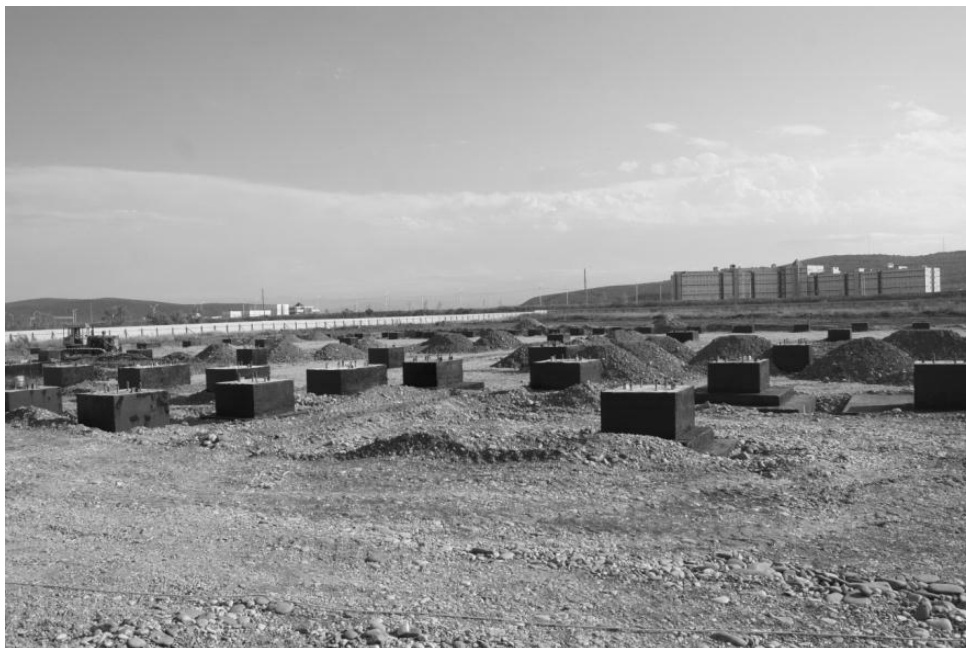
Рис. 4. Столбчатые фундаменты здания гипермаркета «Лента» в г. Грозный
