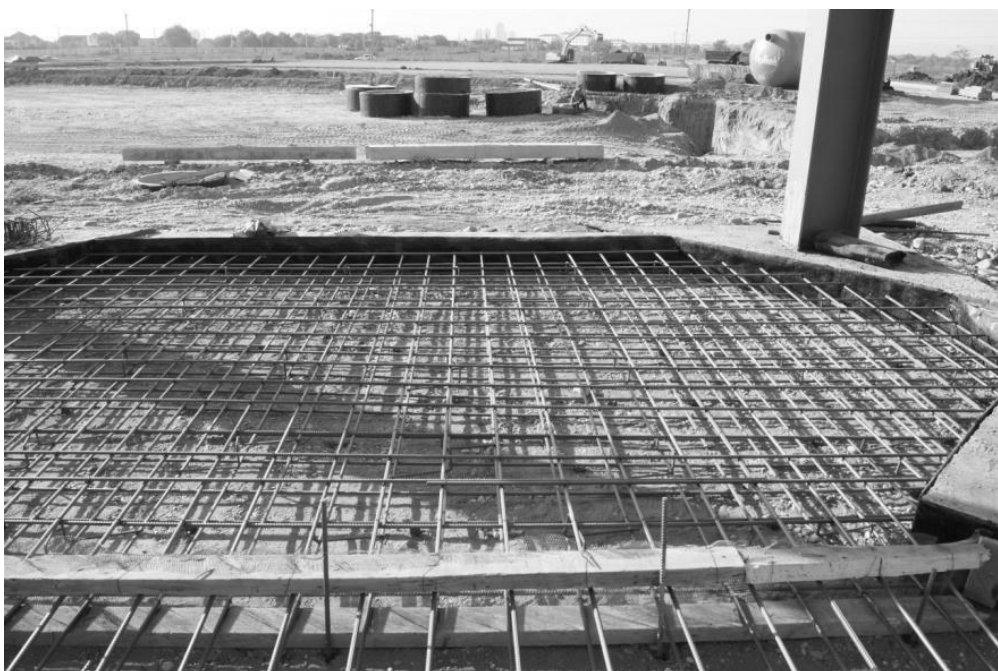
Рис. 6. Армирование железобетонной плиты, объединяющей фундаменты колонн
