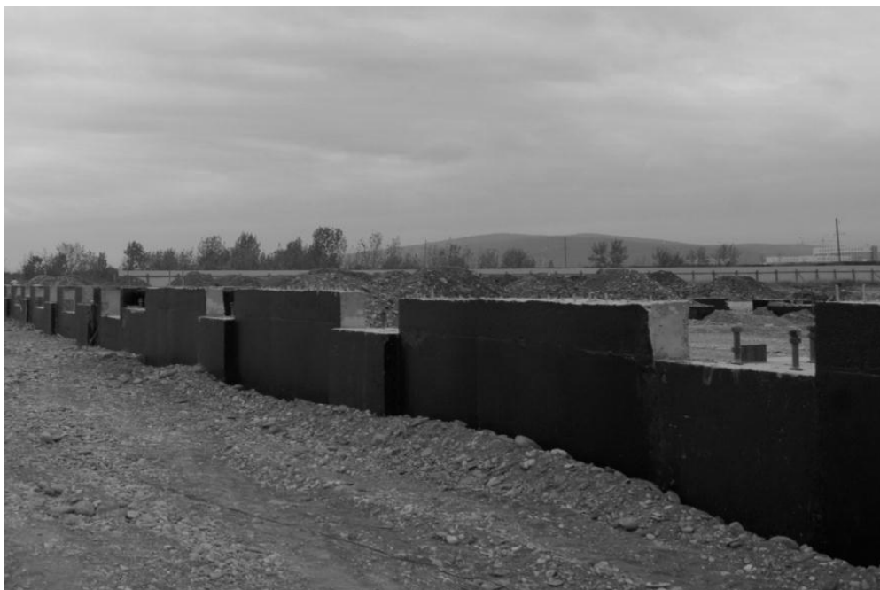
Рис. 7. Распорки, соединяющие фундаменты под связевые панели
