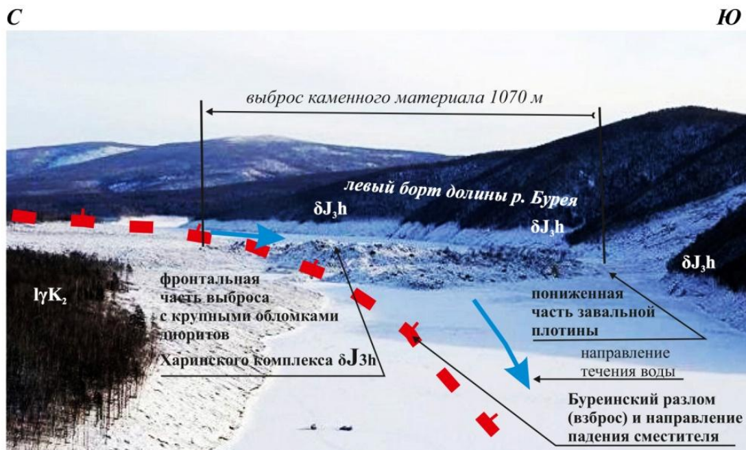
Рис. 3. Вид завальной плотины (11.12.2018 г.) по Бурейскому водохранилищу с нижнего бьефа
