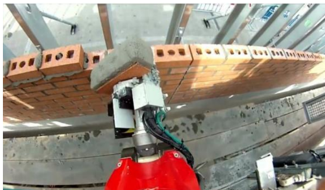
Рис. 2. Робот для кирпичной кладки SAM
