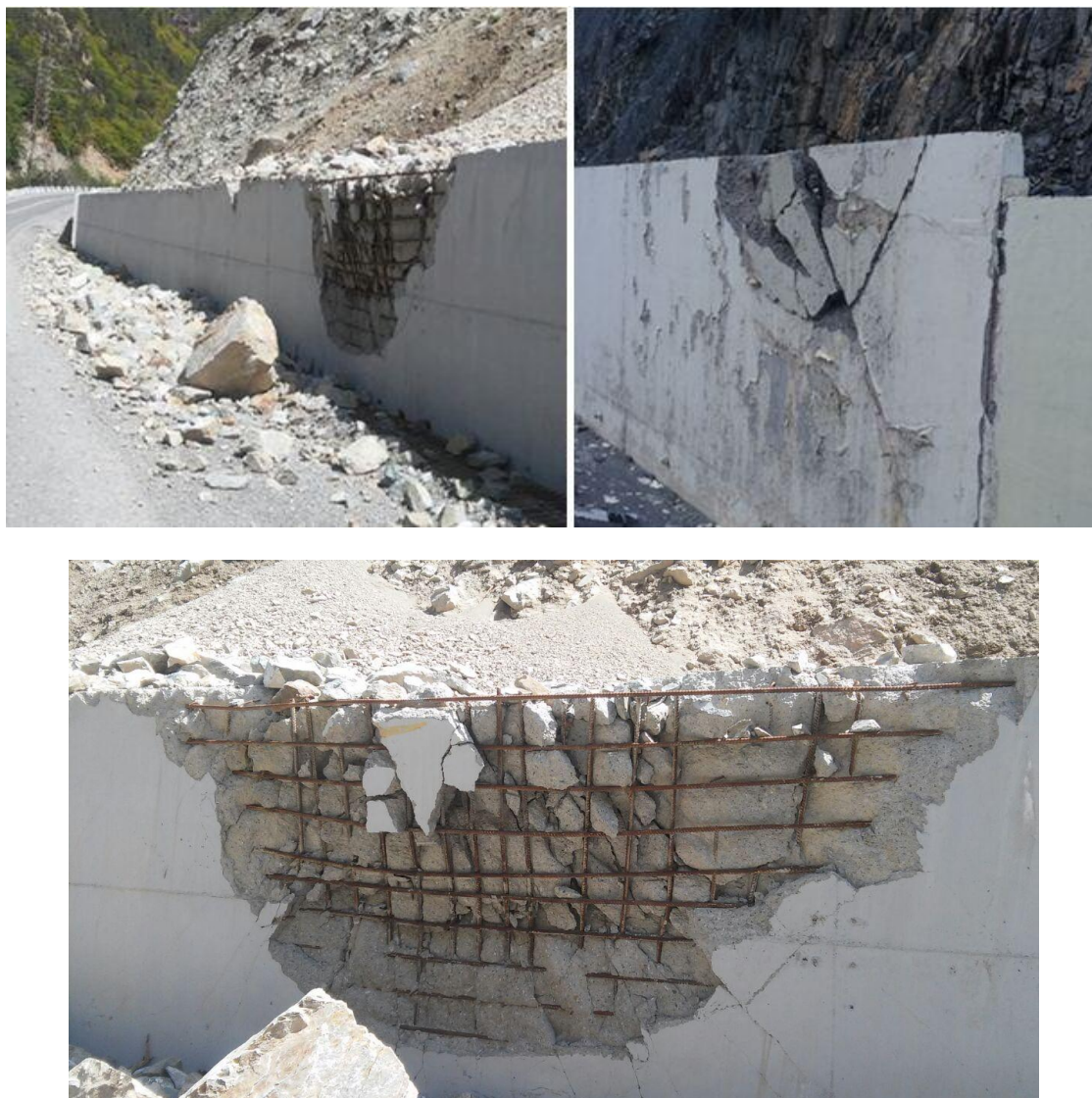
Рис. 2. Последствия обвально-осыпных явлений на горных дорогах Осетии
