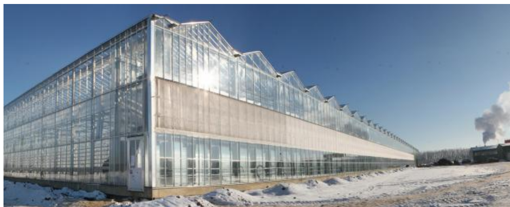
Рис. 9. Теплица пятого поколения, так называемая «полузакрытая теплица», созданная по технологии Ultra Clima
