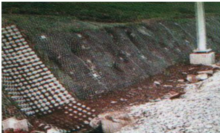
Рис. 13. Легкое крепление откоса (Легкая защита)
