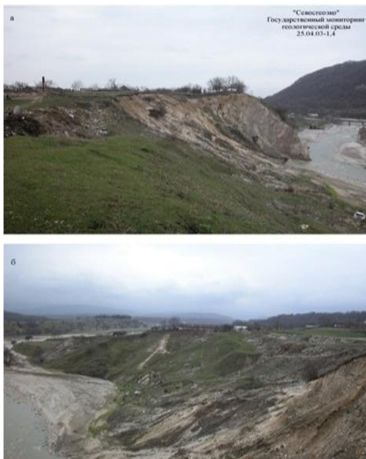
Рис. 1. Активизировавшийся Коринский оползень с угрозой разрушения жилых построек: а) северный фланг, б) южный фланг (25.04.03 г.)
