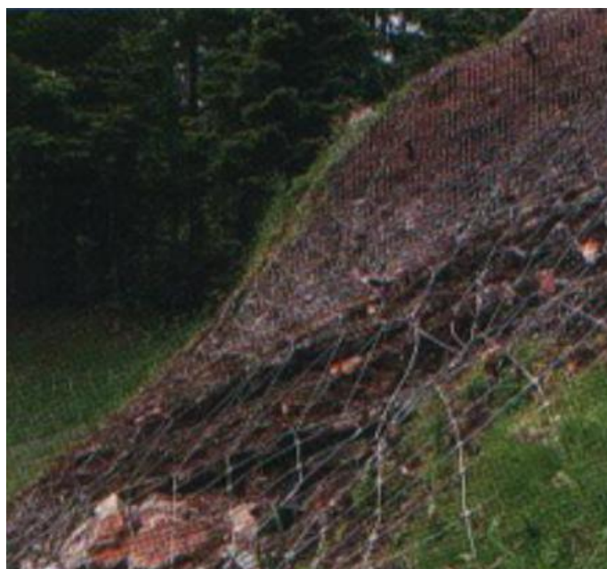
Рис. 14. Тяжелое крепление откоса
