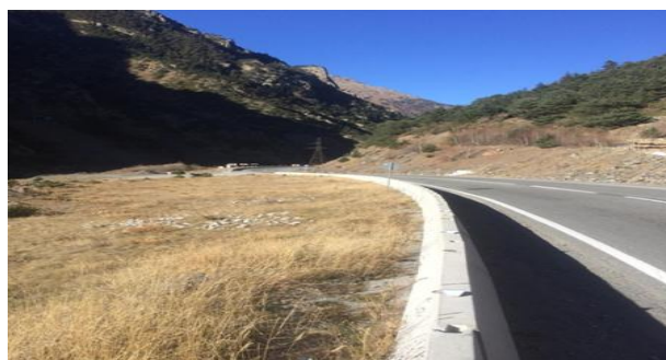
Рис. 2. Созданная полоса для устройства обгона на подъеме
