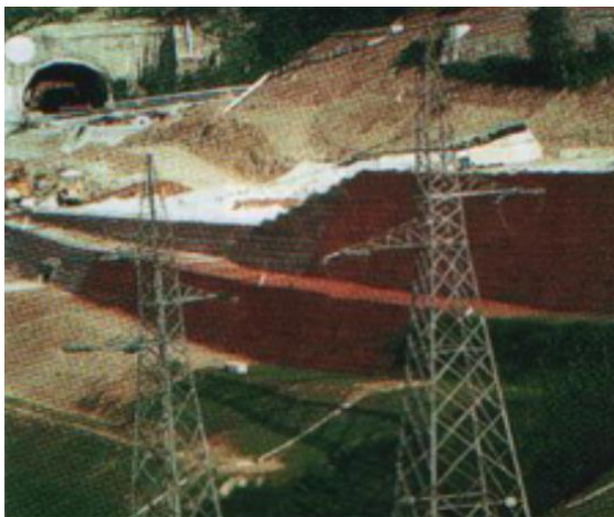
Рис. 15. Система опор TEXTOMUR I
