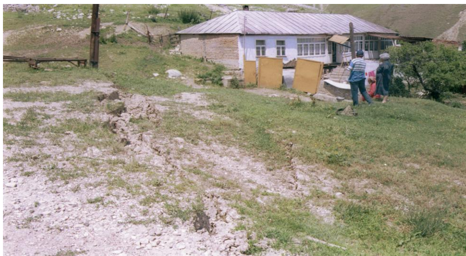
Рис. 5. Заложение головной трещины оползня
