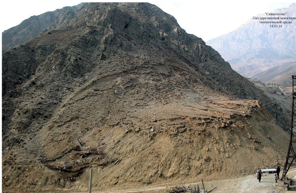
Рис. 2. Оползень в верховом откосе В. Мизур в районе бывшего хвостохранилища (Активизировался 11.01.03 г.)
